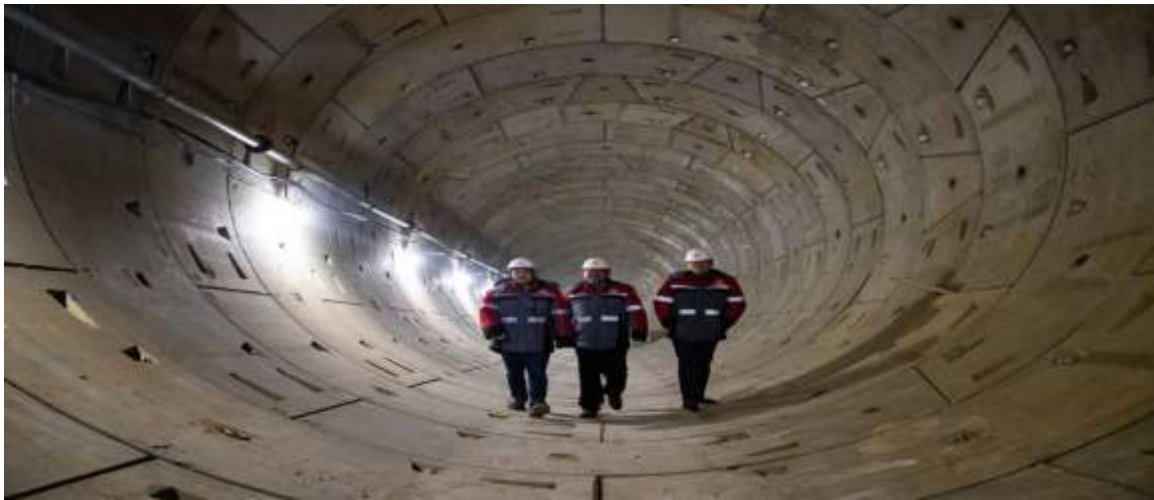
Рис. 4. Отделка коллектора тьюбингом.
